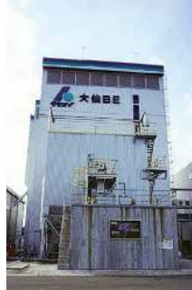
発電ボイラー棟
