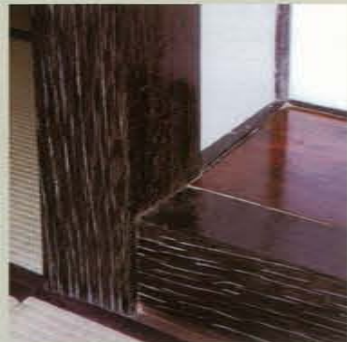
埋れ木の床柱と床框
