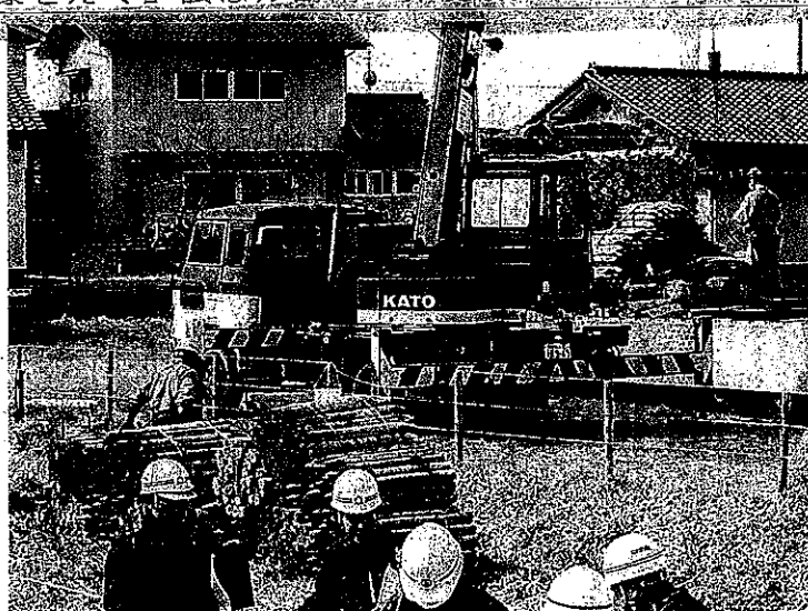
仕留止や掘削作業の進行
