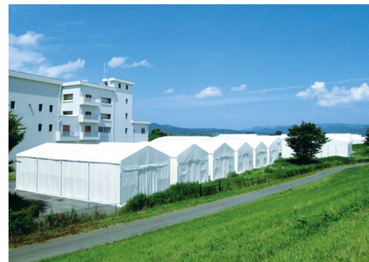
県北浄化センター
