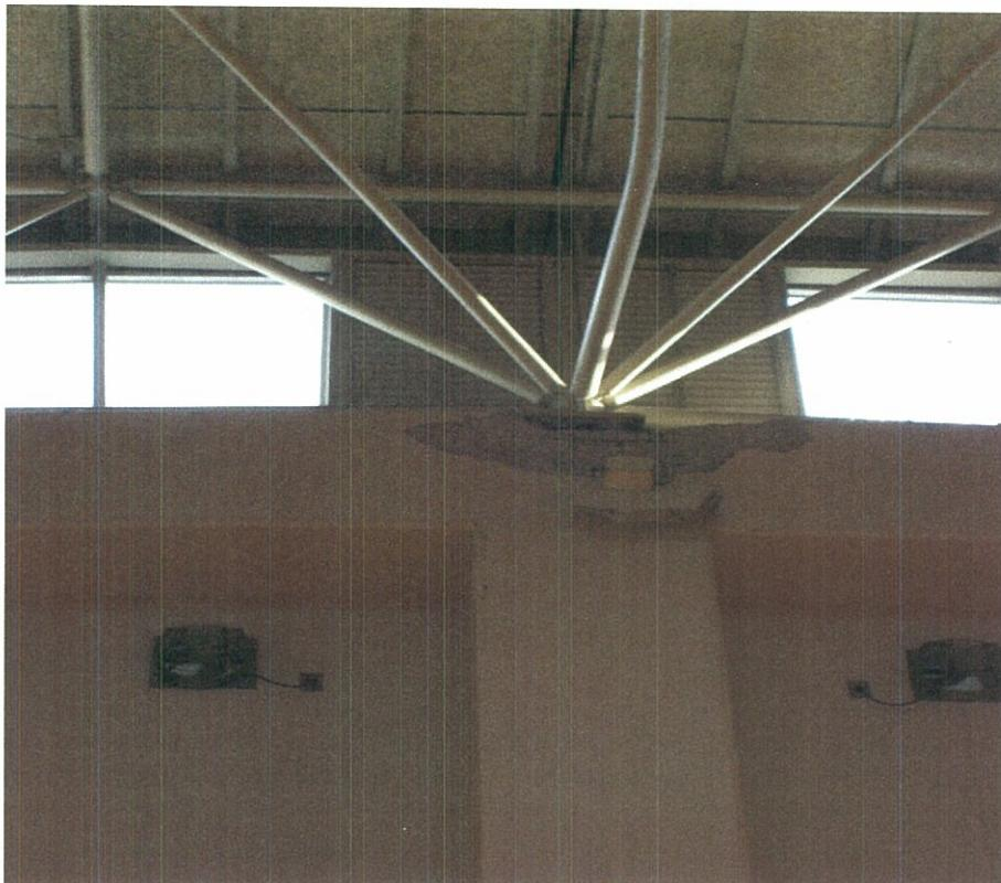
体育館大棟直下のトラスアンカーボルトの脱落と支柱コンクリート破壊、鋼材の変形、屋根大棟部の鋼材が若干変形しているように見える。トラス全体の調査によって改修を検討する。改修完了までは使用禁止。
