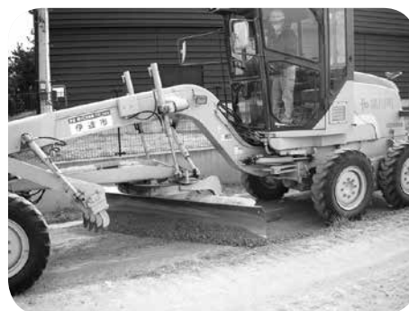
路面整正作業
