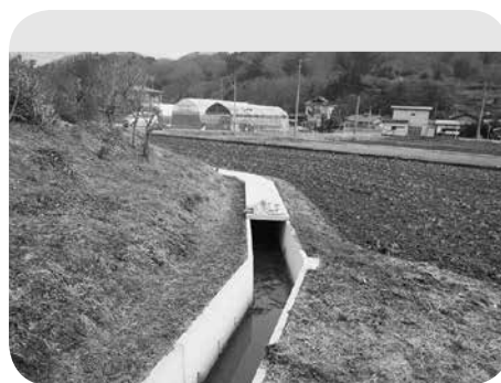
谷地水路 水路布設
