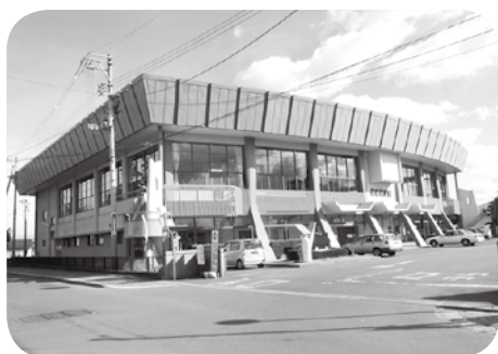
施設全景（駐車場側より望む）
