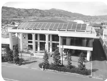
伊達市ふるさと会館に設置した太陽光パネル
