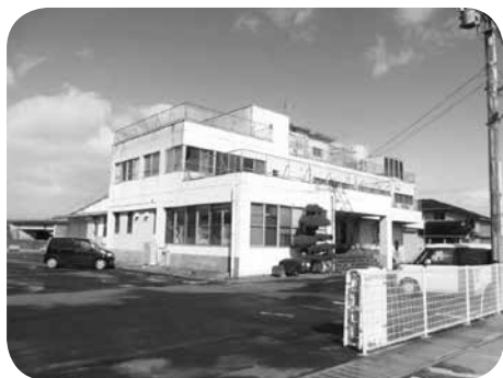
築40年が経過し老朽化が著しい 保原学校給食センター
