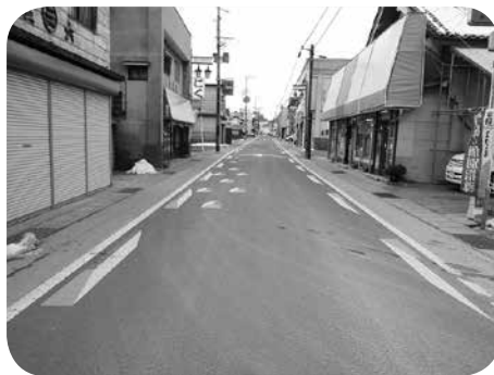
平成 25 年度工事施工箇所 (カラー舗装)
