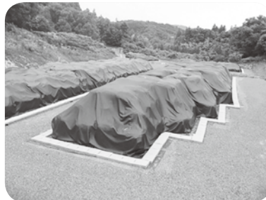
月舘地区布川5番組仮置場
