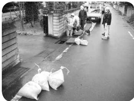
市道側溝除染作業
