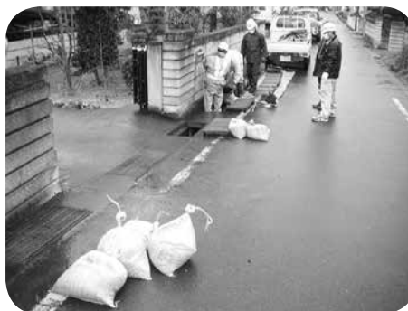
市道側溝除染作業
