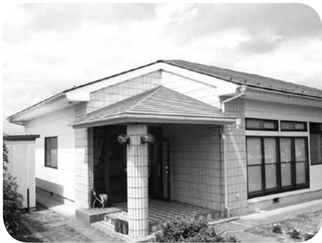
集会所玄関の屋根修繕
