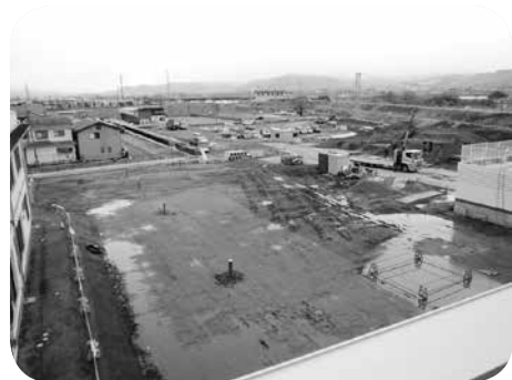
工事を予定している新梁川小学校のグラウンド (屋上より望む)
