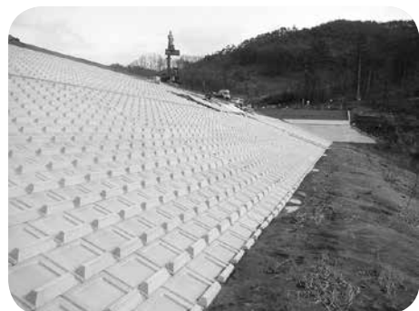
県営ため池等整備事業 足駄木地区
