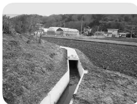
谷地水路 水路布設
