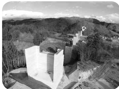
霊山道路区間で最長となる 月舘高架橋の工事状況
