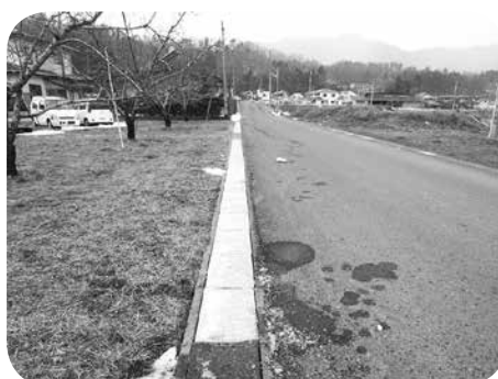
堀ノ内線 御代田字堀川
