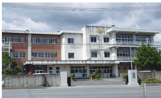
耐震補強・改修を行う上保原小学校 工期は平成30年1月31日まで
