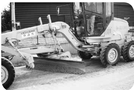
路面整正作業
