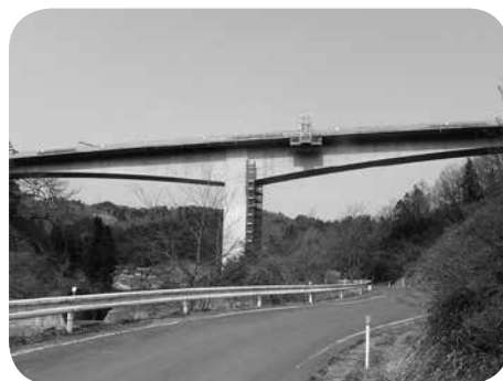
犬飼大橋（工事中）
