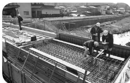
橋梁修繕工事
