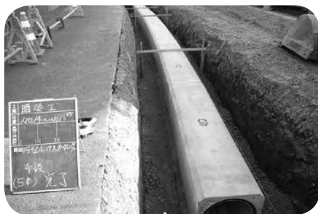
上町排水路整備
