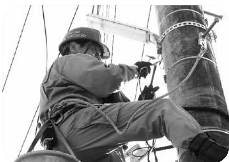
街路灯新設作業
