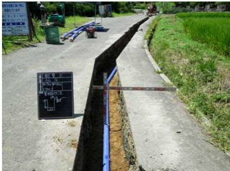
石綿セメント管更新工事
