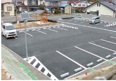
21台が駐車できる駐車場を整備
