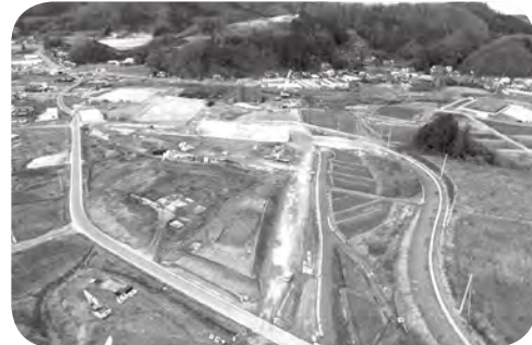
（仮称）霊山 IC の工事状況（平成 29 年 1 月現在）
