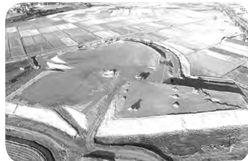
（仮称）国道 4 号 IC の工事状況（平成 29 年 1 月現在）
