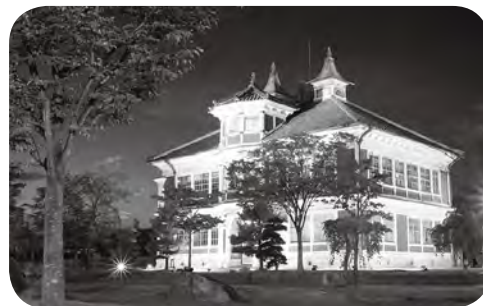
ライトアップされた旧亀岡家住宅
