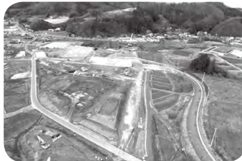
（仮称）霊山 IC の工事状況（平成 29 年 1 月現在）
