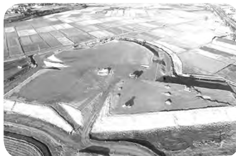
（仮称）国道 4 号 IC の工事状況（平成 29 年 1 月現在）
