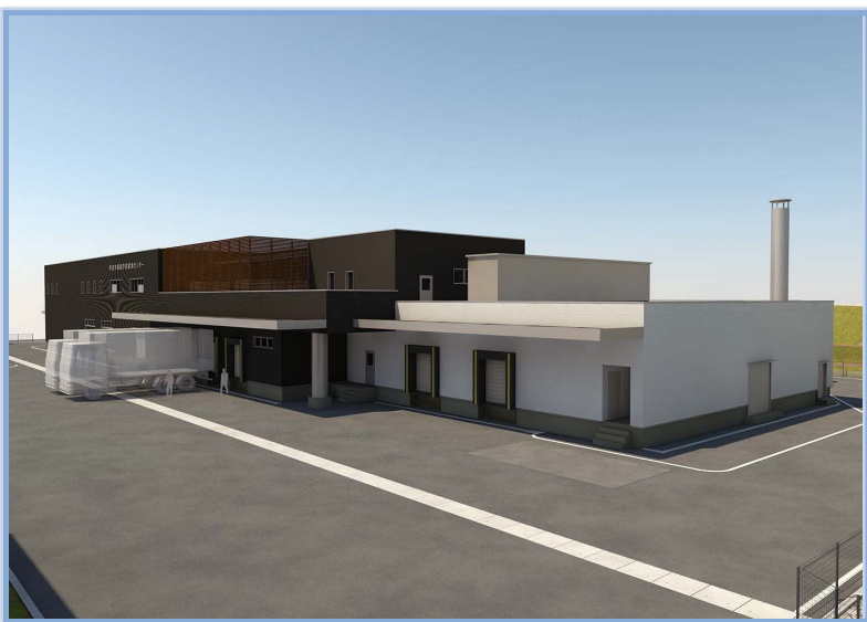
現在の保原学校給食センターの隣に建設が進められている 保原学校給食センター完成イメージ
