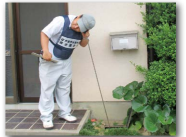
漏水調査の様子
