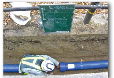
耐震管への取替工事
