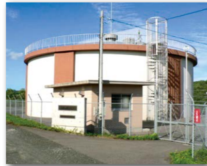
配水池（梁川町南中峰）
