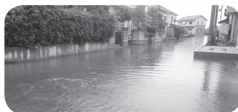
荒町地内道路冠水
