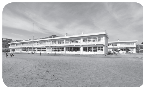
掛田小学校校舎
