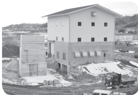
県営湛水防除事業 五十沢排水機場（仮）
