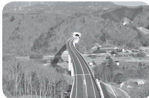
月館高架橋と境ノ目トンネル
