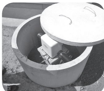
事業完了検査時の写真（井戸写真）
