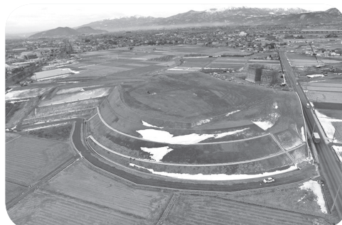
（仮称）国道4号ICの工事状況（H30.1 現在）
