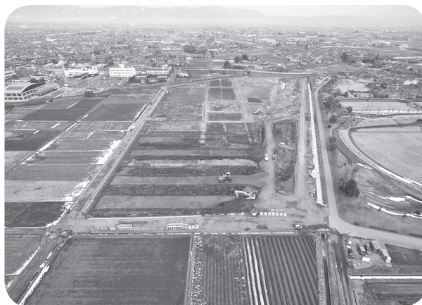
保原総合公園拡張整備事業の工事状況（平成 30 年 2 月末）
