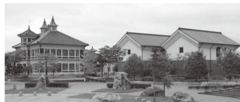
(写真左：旧亀岡家住宅 右：資料館)
