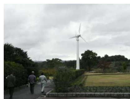
風力発電施設
