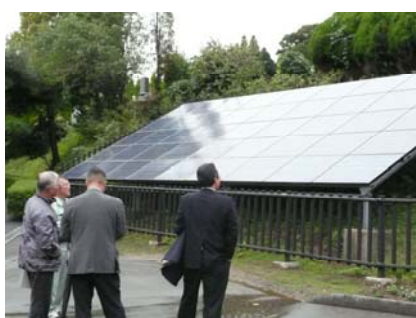
太陽光パネル
