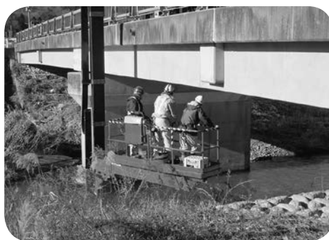
橋梁点検車による作業状況
