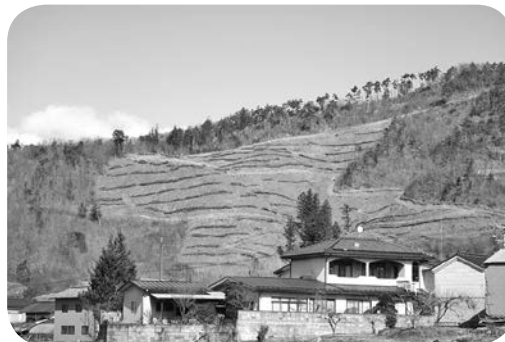
森林整備状況写真 (霊山地域泉原鹿頭山地区)
