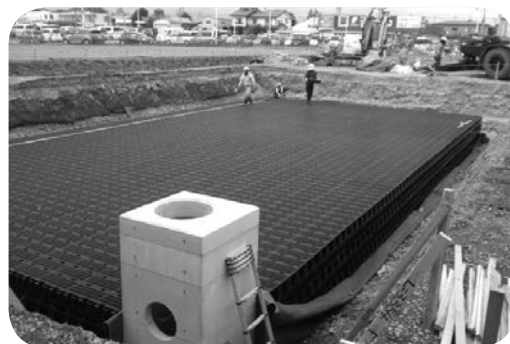
雨水浸透式貯留槽設置工事
