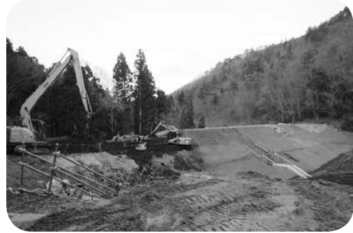
県営ため池等整備事業【堀沢地区】 堀沢ため池改修
