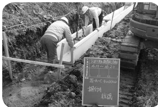
活動組織による地域組織活動【水路改修】
