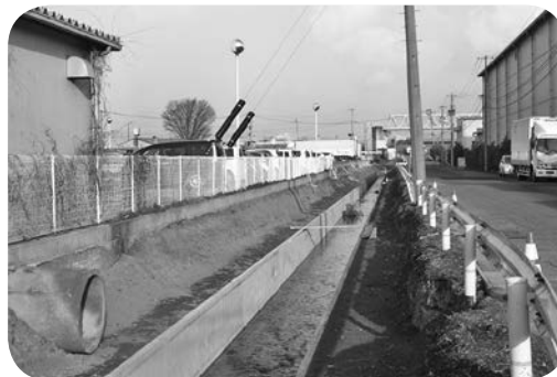
農業用水路新堀川改修工事（伊達市伏黒字八反田地内）
