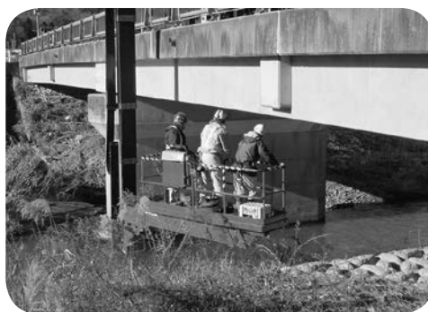
橋梁点検車による作業状況
