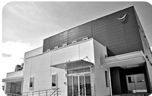
平成 30 年 8 月から稼働した中央給食センター
