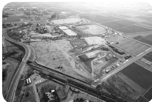
保原総合公園拡張整備事業の工事状況（平成31年2月）
