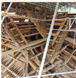
解体中の本殿
