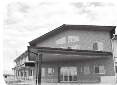
保原総合公園に完成した簡易宿泊所
