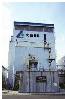
発電ボイラー棟
