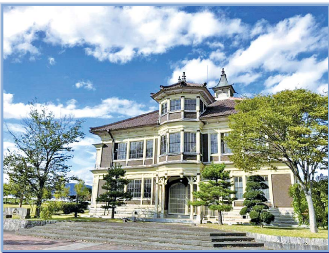
旧亀岡家住宅
