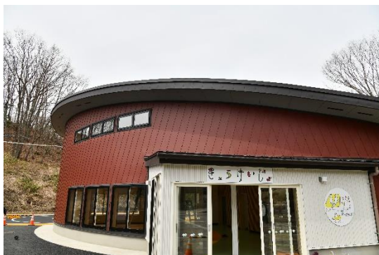
新築した休憩施設
