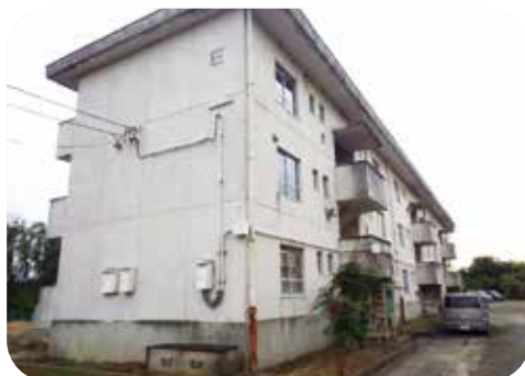
改修工事を行う桜岳団地
