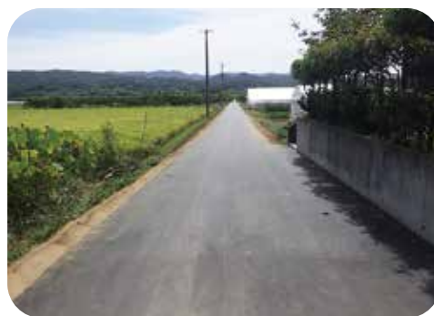
現道舗装（施工後）
