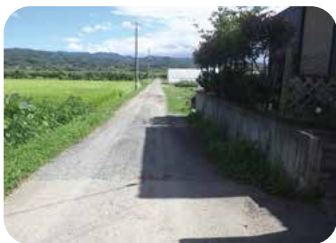
現道舗装（施工前）
