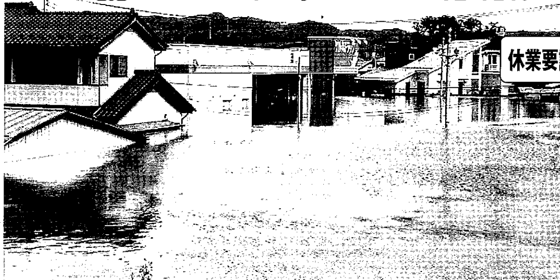
2019年10月13日 梁川町川北地区の浸水被害状況
