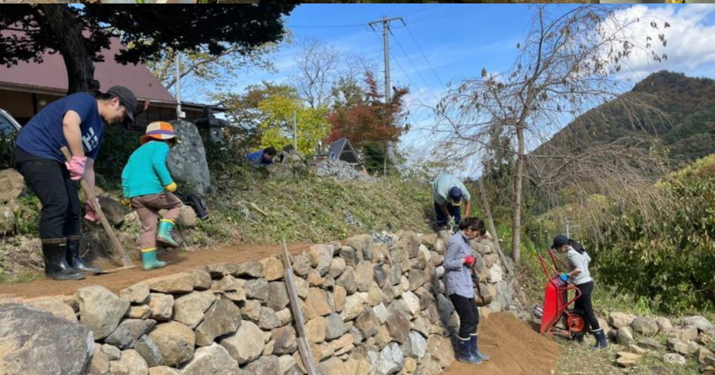
3月の地震で崩れた石垣の修復作業
