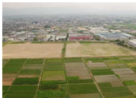
新たに 13.9ha を整備した 伊達市新工業団地
