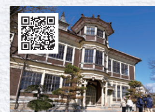
旧亀岡家住宅
