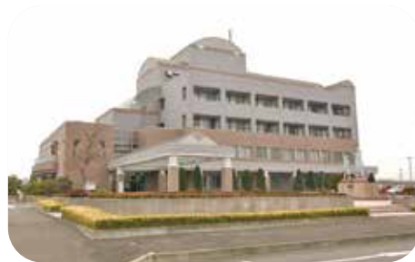
改修工事を行う梁川総合支所庁舎
