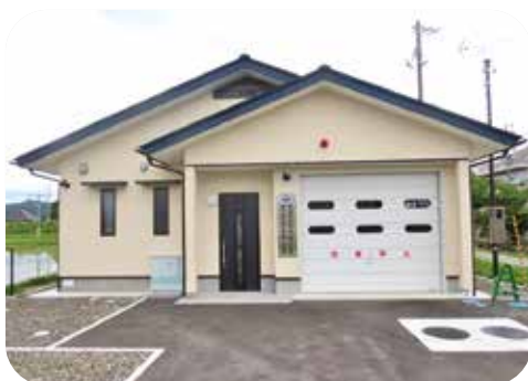
新築された消防屯所
