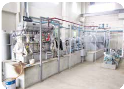
梁川第二排水機場
