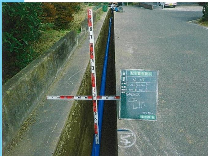
古い石綿管を撤去し、新しい水道管を布設している状況
