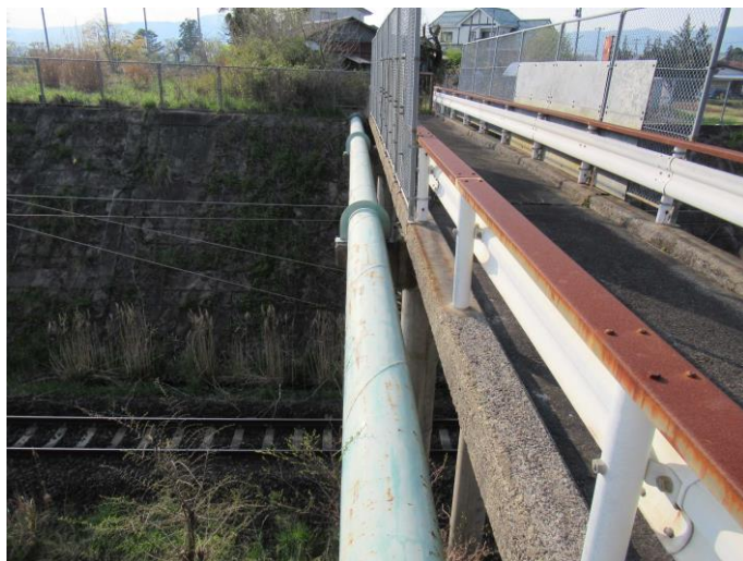
写真 6-2-3 茶臼山橋 添架水管橋状況
