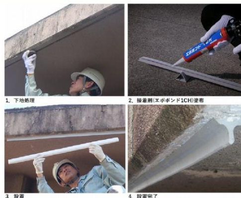
ウォーターカッター施工状況
