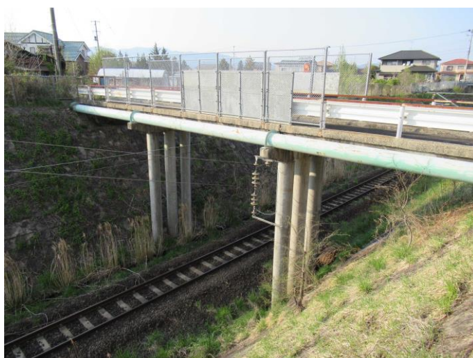
写真 6-2-2 茶臼山橋 側面状況
