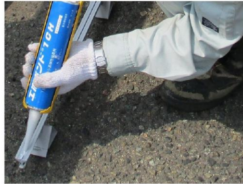
施工状況(接着剤塗布)
