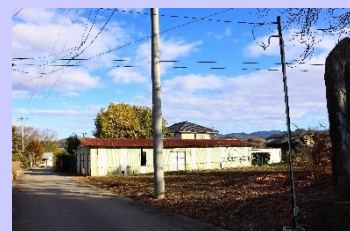
電柱(支柱線含)
