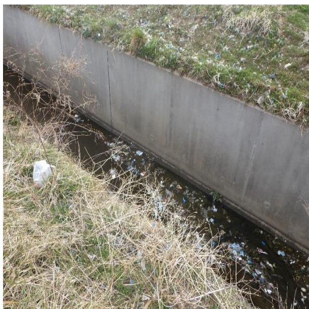
R7.3.31 撮影(東側排水路)
