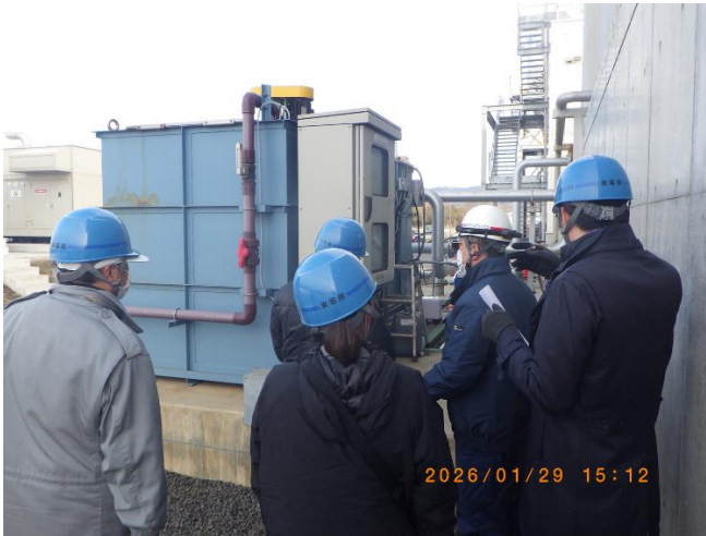
排水処理装置
