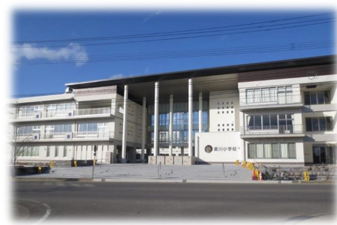
梁川小学校（改築） H22～H28 51.8億円
