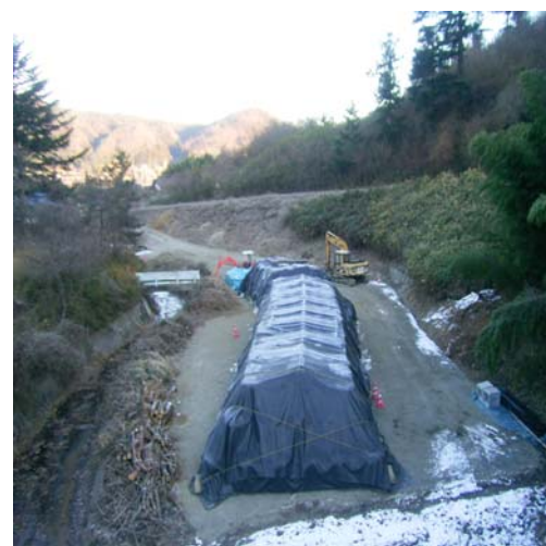
仮置き場完成の全景
