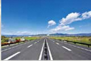
▲整備された東北中央自動車道
